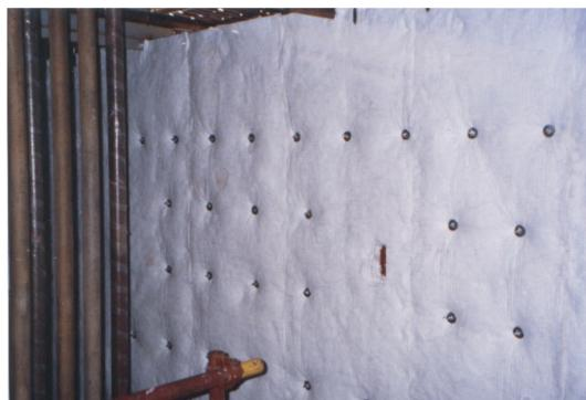
[低温加热炉热面材料]
