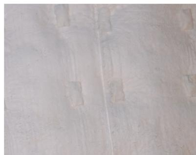
[低温炉锚固钉保护]
